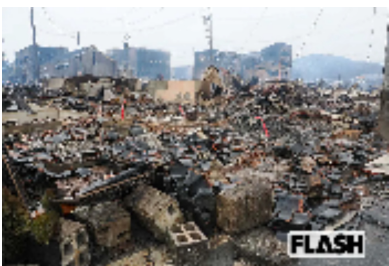
輪島朝市地域の被害
